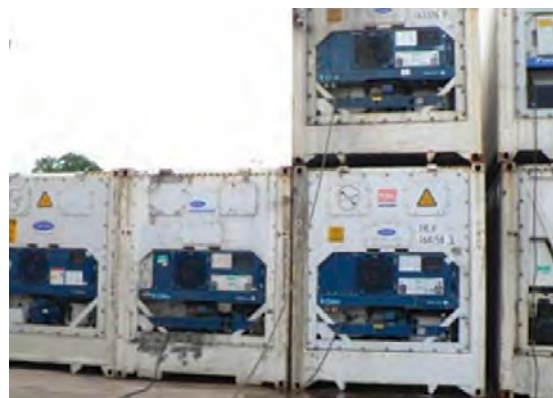
Figure 61 : Branchement électrique des containers lors des phases statiques (Photo : Jean-Yves Rey)
