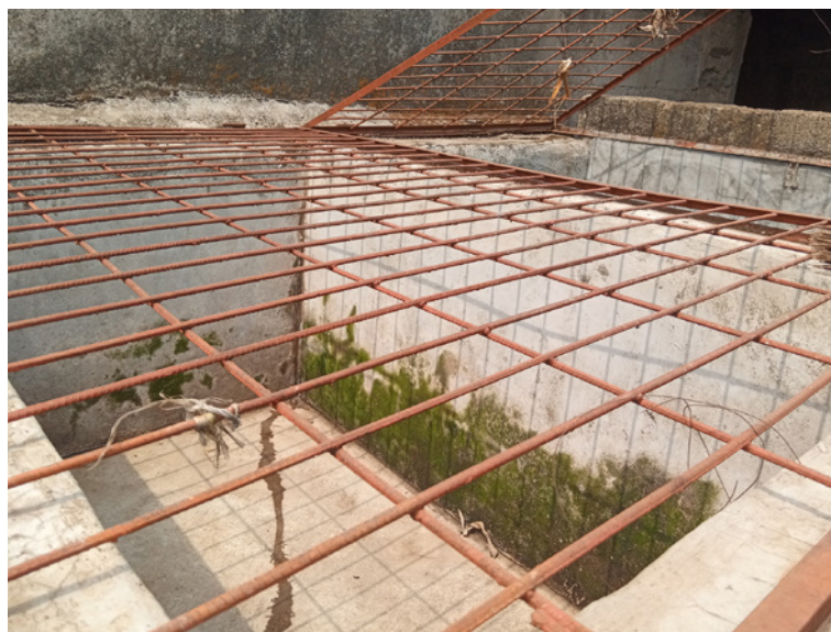
Figure 32 - Mauvais entretien de bac de rouissage : Fissures et développement des adventices dans le bac du rouissage
