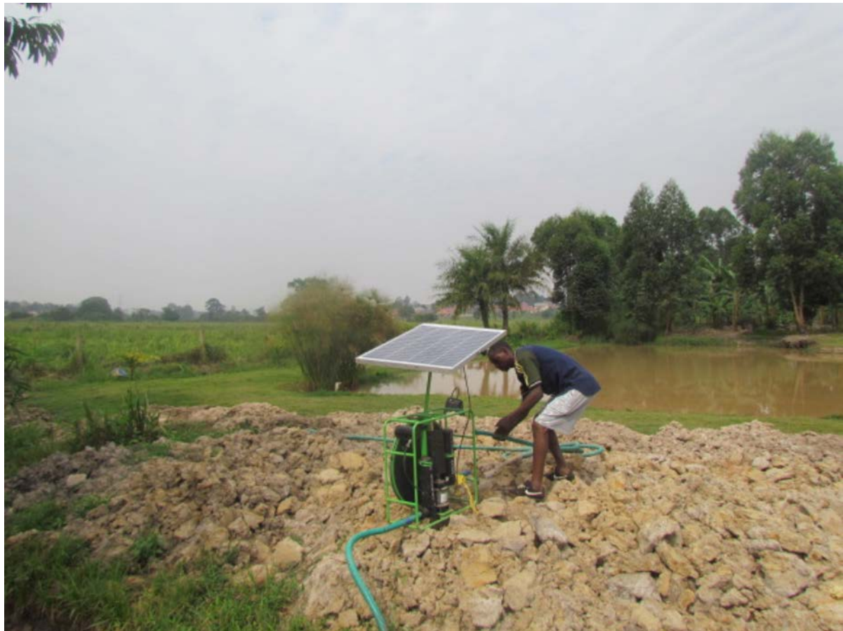
Figure 7 - Pompe à eau simple à énergie solaire – pas de source
